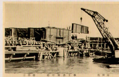
言問橋 橋桁架設工事 (昭和2年頃)
