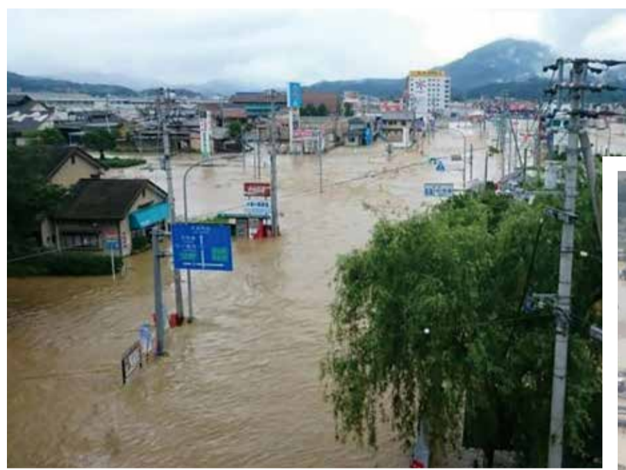
▲愛媛県の浸水状況 (平成30年7月7日撮影 大州河川国道事務所提供)
