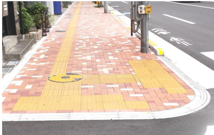
【バリアフリー化された歩道の例】
