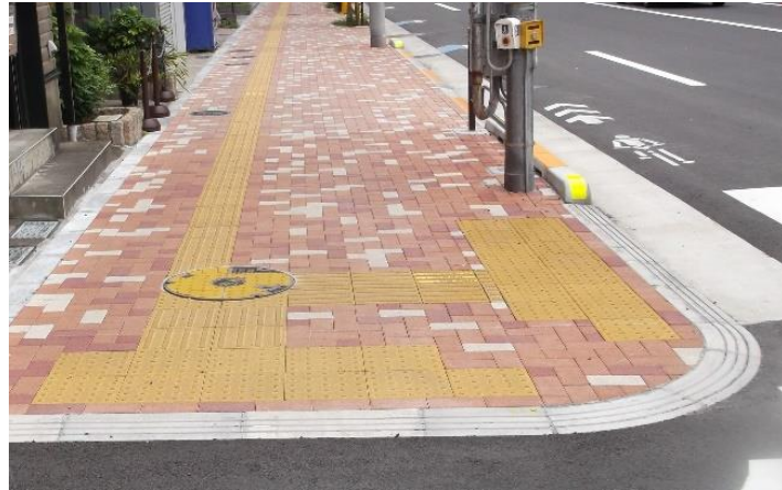
【バリアフリー化された歩道の例】
