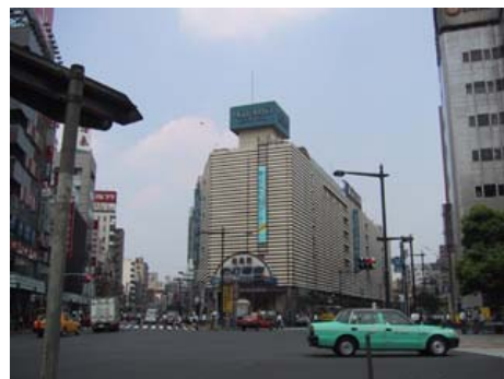
現在の東武ビル
