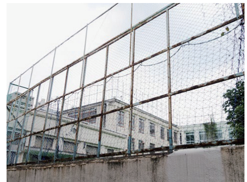
旧坂本小学校跡地
