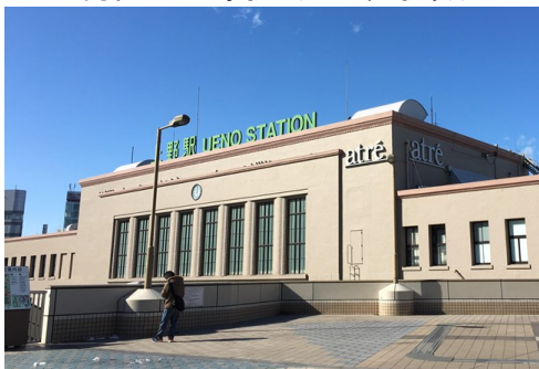
現在のの上野駅（2 代目駅舎）
