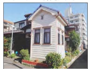
和風住宅に増築した洋間部分をシンボリックにデザイン
