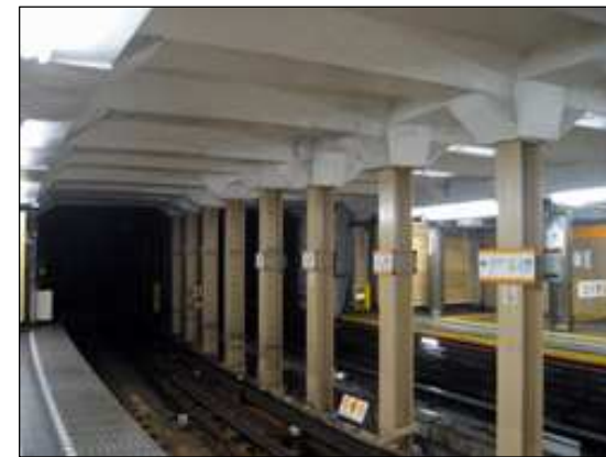
銀座線上野駅の鉄鋼框(かまち)構造 日本土木学会の認定する土木遺産に選定されている(東京メトロHPより)
