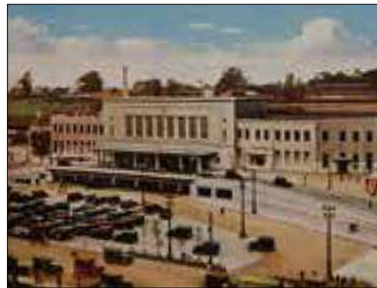
竣工当時の二代目JR上野駅舎
