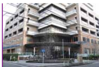
学校跡地の活用事例 旧二長町小学校（台東一丁目）
