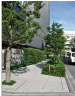
歩道状空地の整備イメージ …建築物の壁面後退により整備された歩道状空地
