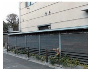
塀の素材と植栽の工夫により修景しています(谷中)
