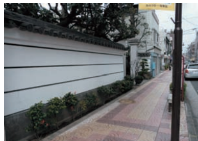
塀を若干下げ、前面に植栽を設け、まち並みを演出しています。(かっぱ橋本通り)
